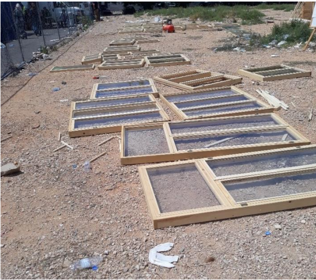
Fenêtres et portes préparées dans les premières semaines
