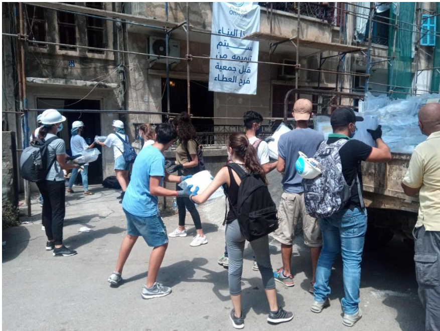
Déblaiement des décombres
